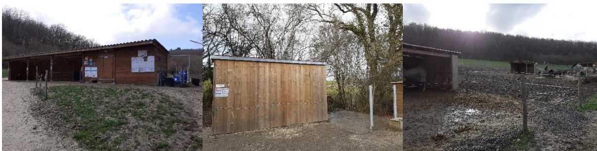
Photo 8. Bâtiment dédié au stockage de fourrage et à l'accueil du public (à gauche) ; Sellerie (au centre) ; Abris pour les chevaux (à droite)
